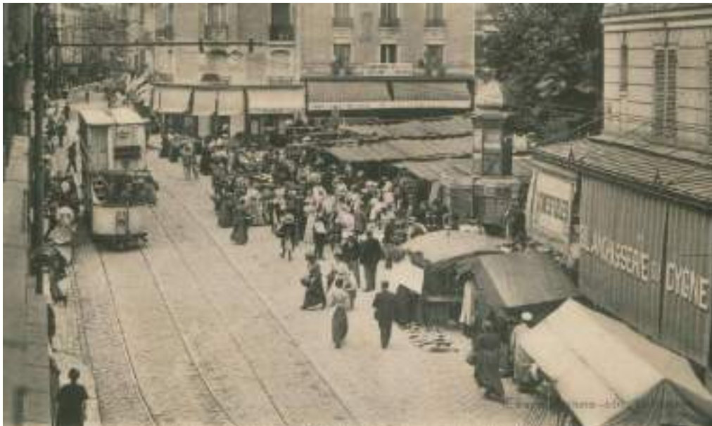
Vue de puis la rue Charles de Gaulle, en contrebas de l'esplanade du marché
