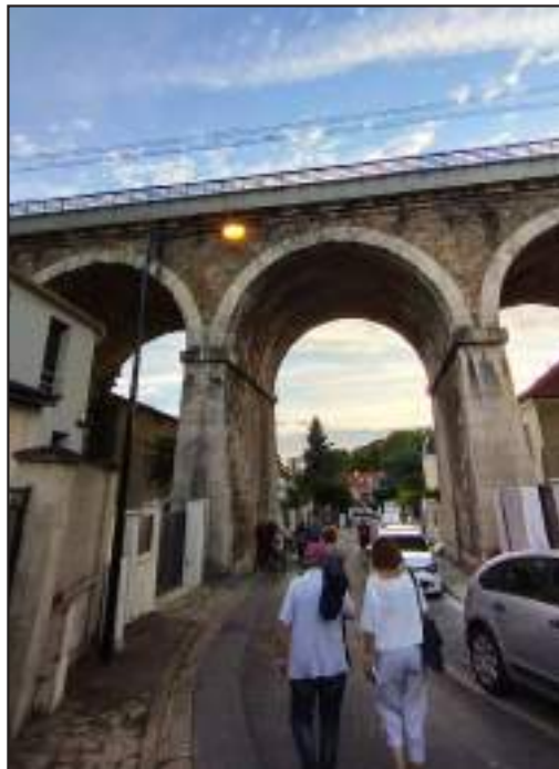
Passage sous le Viaduc ferroviaire à Joinville-le-Pont
