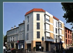
À Vincennes, la construction d'un immeuble de six logements sociaux et l'installation d'un restaurant a permis de réhabiliter un angle de rue dégradé © Vincem
