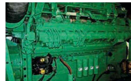
Un moteur de cogénération, qui permet de produire électricité et chaleur.
