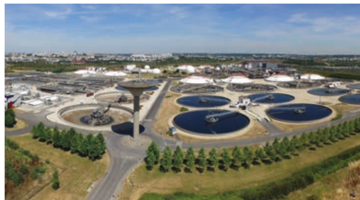
L'usine Seine amont, à Valenton (94).
