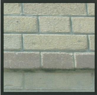
Les briques destinées à rester apparentes sont des briques pleines. Elles peuvent être appareillées de différentes manières : en joints croisés, en assemblages de différentes couleurs. Les briques silico-calcaires apparaissent au début du XXème siècle ; de couleur grège, elles sont assez friables. Les briques de meilleure qualité sont celles en terre cuite. Les maçonneries de briques sont hourdées au plâtre ou à la chaux ; c'est après 1920 que l'on traite systématiquement les joints en ciment.
